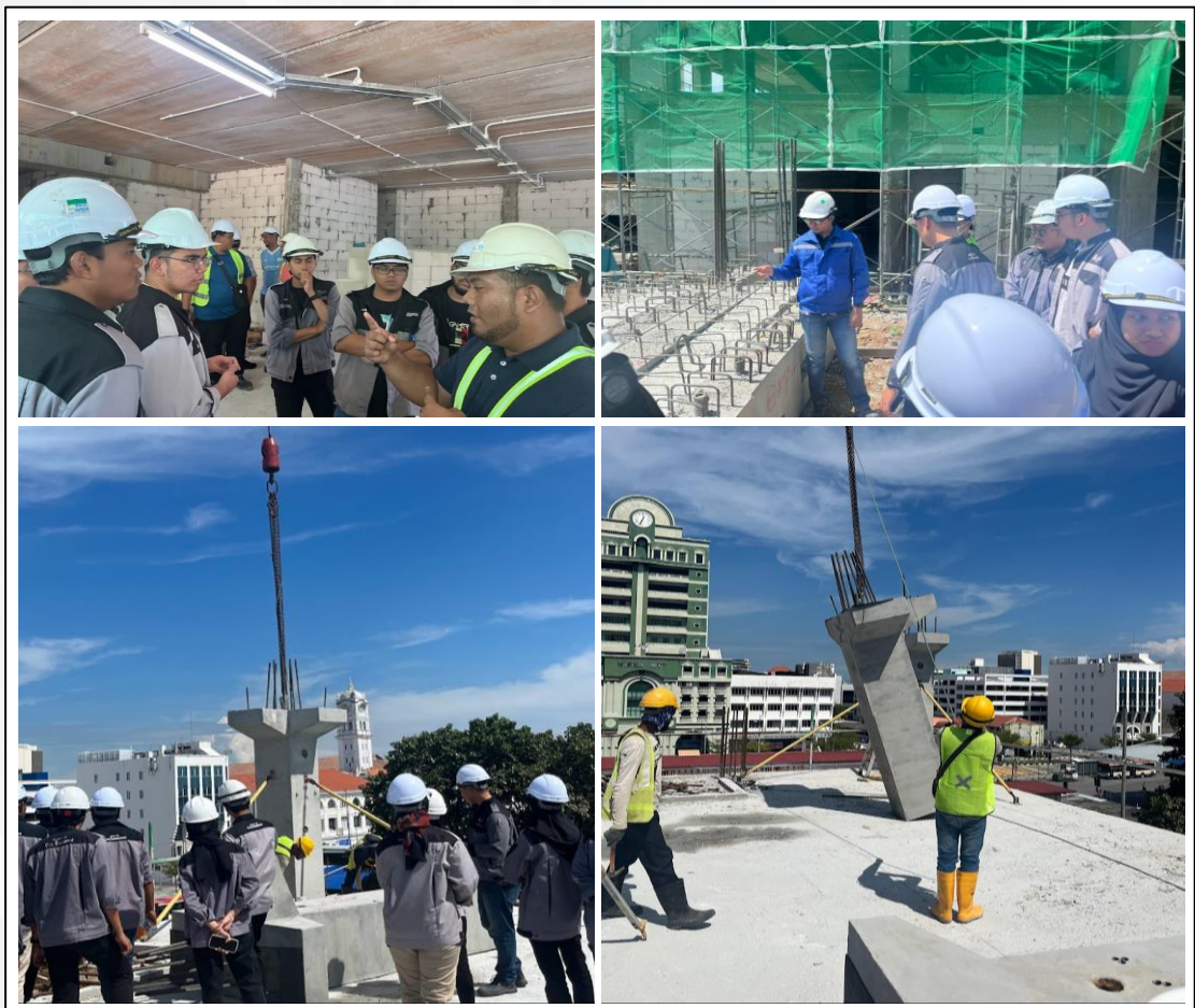
Gambar 3: Aktiviti pemasangan tiang IBS di tapak bina
