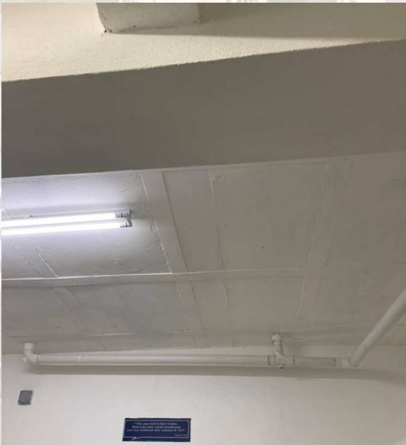
Keadaan soffit slab setelah dibaikpulih dengan pemasangan carbon fiber .
