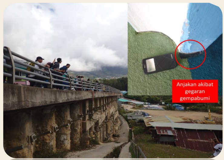
Gambar 7: Keadaan sekitar Masjid Kundasang dan gambar kecil menunjukkan anjakan salah satu tiang dan lantai Masjid Kundasang
