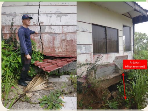
Gambar 8: Kerosakan struktur major di beberapa bilik penginapan di Zen Garden Resort
